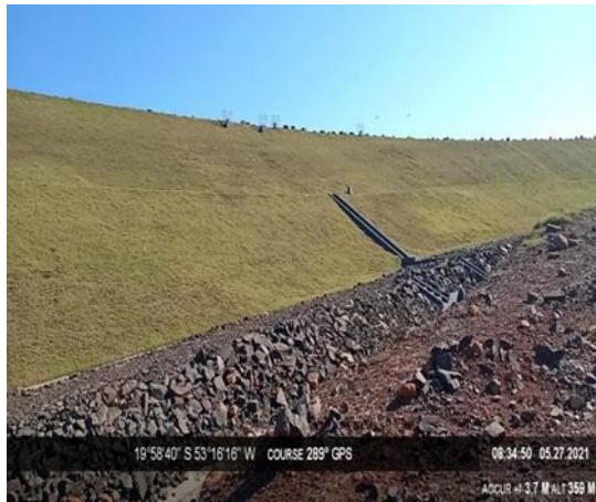
Figura 24 - Área de Acesso provisório à jusante (ME). Maio de 2021.
