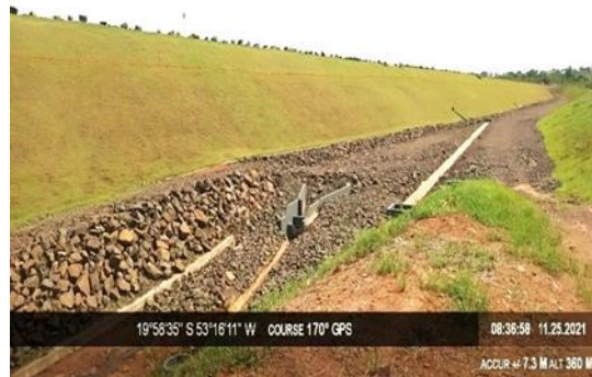
Figura 25 - Área de Acesso provisório à jusante (ME). Novembro de 2021.
