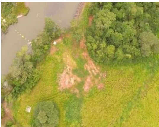
Figura 9 - Área da Captação de água à jusante do barramento (MD). em maio/2021.
