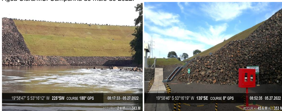
Figura 7. Talude de contenção da PCH Verde 4, contendo área cascalhada e gramada. Município de Água Clara/MS. Campanha de maio de 2022.
