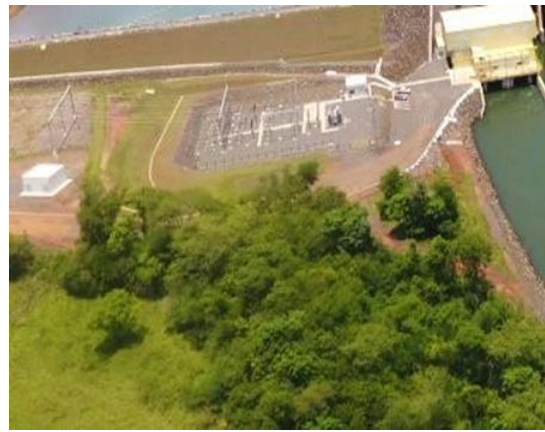
Figura 22 - Área próxima à casa de força e subestação. Novembro de 2021.
