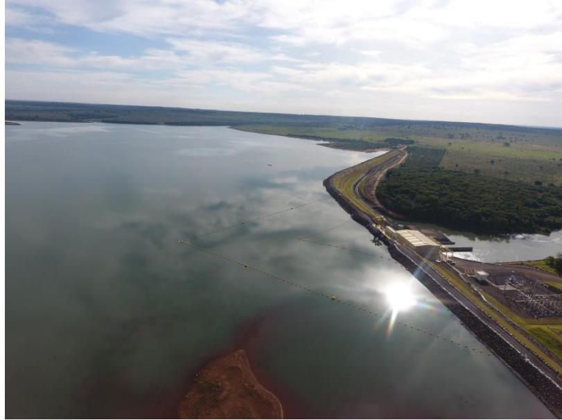
Figura 3. Vista aérea da PCH Verde 4, compondo as áreas de amostragem do reservatório e a jusante do barramento, incluindo a casa de força e subestação. Campanha de maio de 2022.
