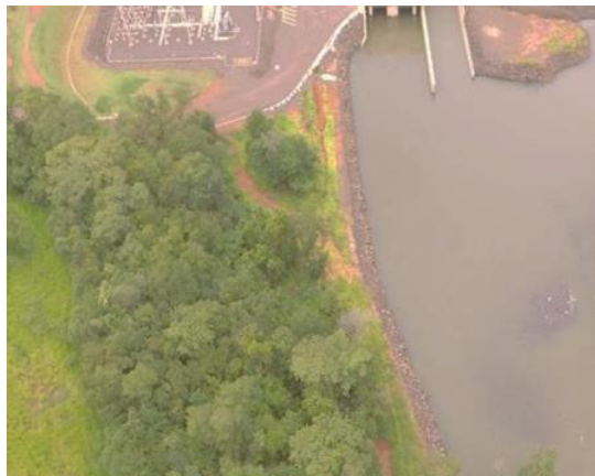
Figura 21 - Área próxima à casa de força e subestação. Maio de 2021.
